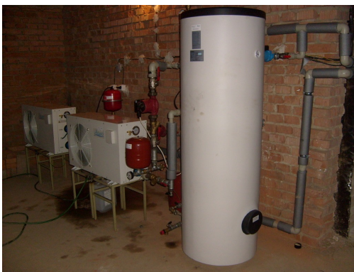
Instalace tepelných čerpadel celkem: 110.315,-Kč
