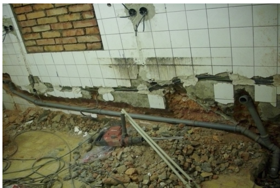
Rekonstrukce kuchyně celkem: 86.810,-Kč
