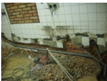
Rekonstrukce kuchyně celkem: 86 810 Kč
